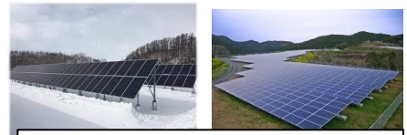
北海道(左)と宮崎(右)の太陽光パネル。緯度が違うため、太陽から受ける光量が違うので、角度が大きく違う。
